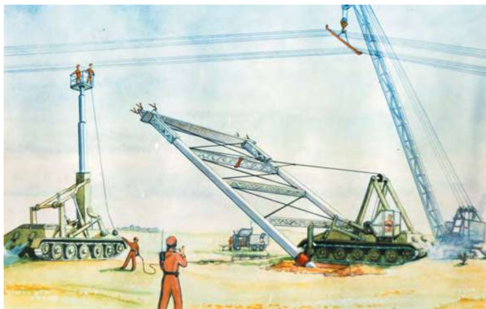
Рисунок 2.27 – Установка промежуточной опоры
