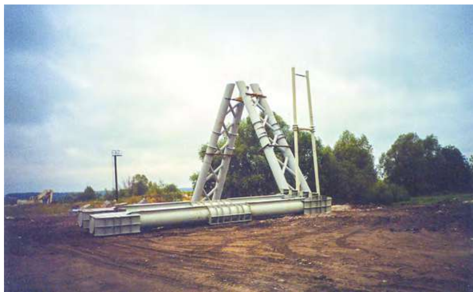
Монтаж узлов второй анкерной опоры на строящемся стенде СТЮ «Путевая структура», г. Озёры Московской области, август 2001 г.
