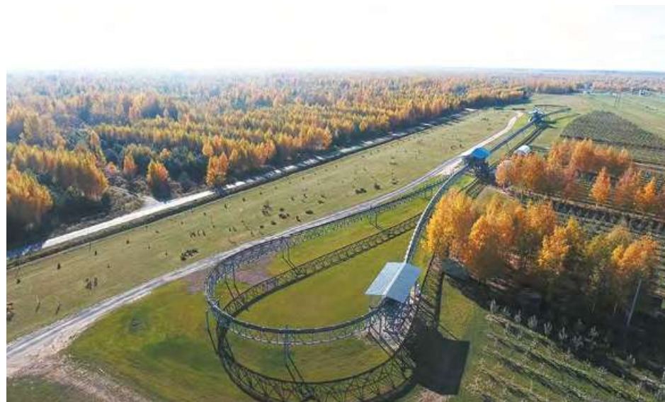
Грузовой комплекс SkyWay, на эстакаде которого располагаются две конструкции: ленточный конвейер (юнитранс) и грузовые модули (юнитрак), ЭкоТехноПарк, г. Марьино Горка, 2018 г.
