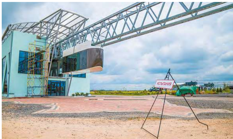
Испытания бирельсового юнибуса, ЭкоТехноПарк, г. Марьино Горка, 2018 г.
