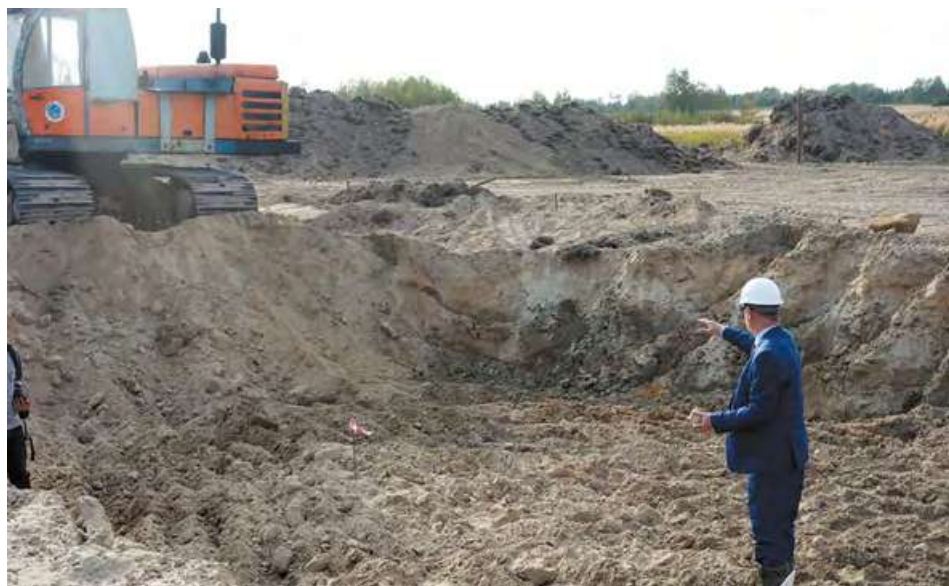
Рытьё котлованов под анкерную опору в ЭкоТехноПарке, г. Марьина Горка, август 2015 г.
