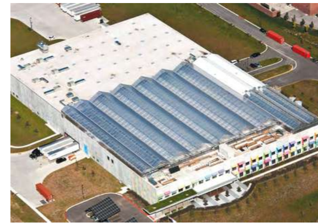
Рисунок 2 – Теплица на крыше здания компании Method в г. Чикаго, США [4]
