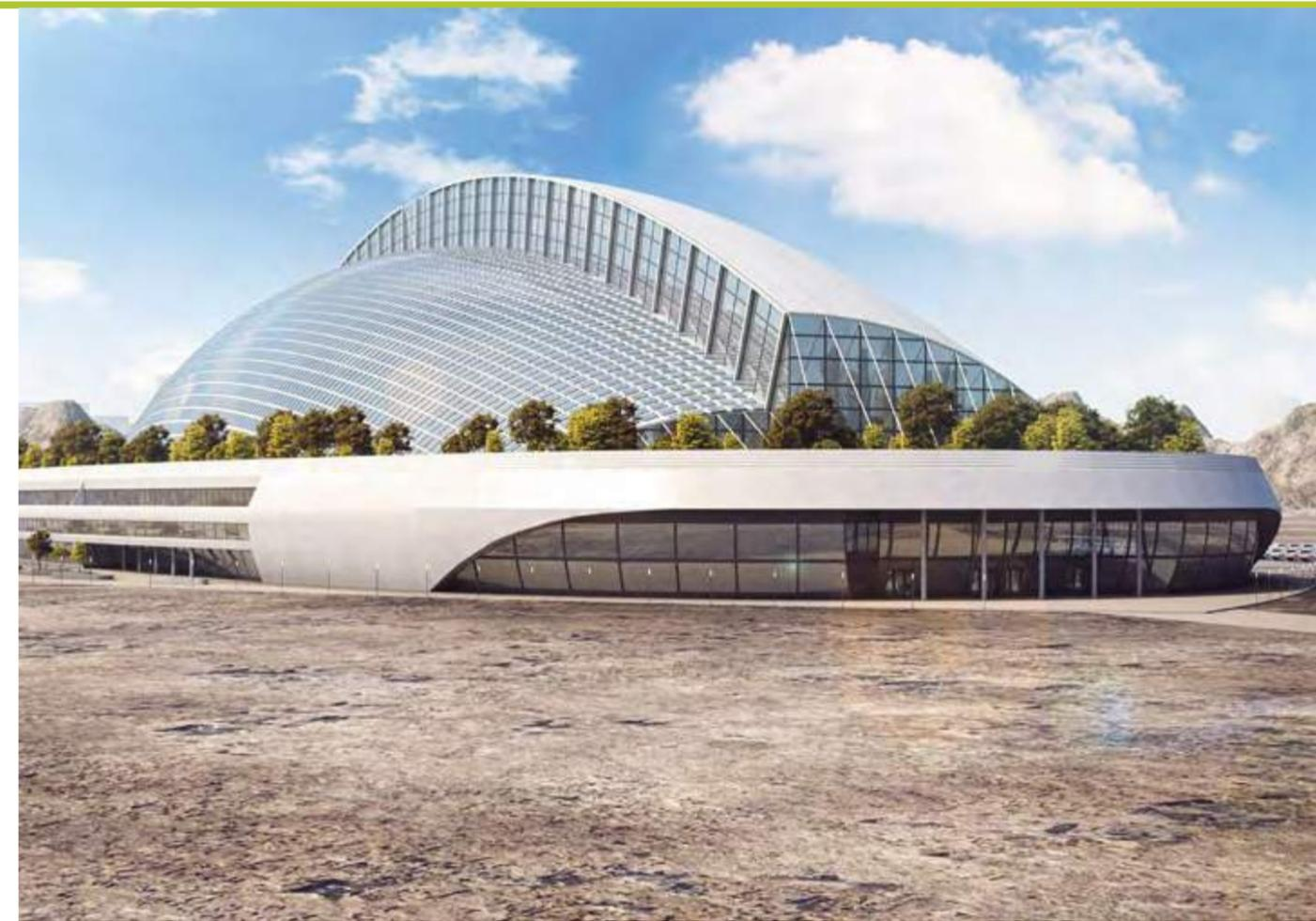
Рисунок 16 – Визуализация ЭКД-Земля (вариант) с конструктивным решением в виде фрагмента тора с продольным разрезом и поднятием части покрытия
